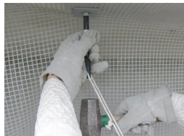
打ち込み棒とハンマーで打設
