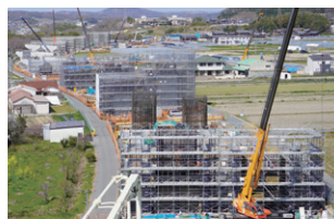
神戸西バイパス（第五平野西高架橋）
