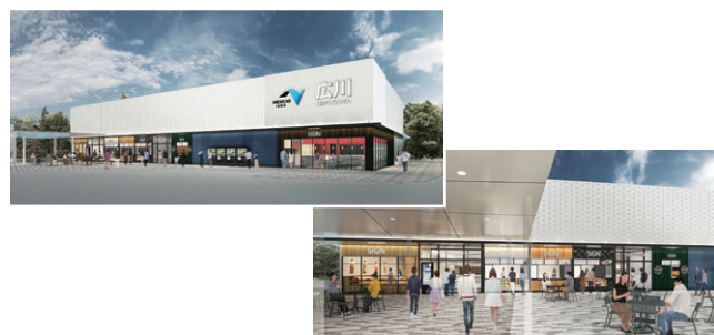
工事中の九州自動車道 広川SA(上り線)リニューアルオープンイメージ
