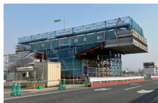
大和北道路（発志院北第一高架橋）
