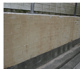
④ 落下したタイルを除去して作業完了 ※タイル除去後コンクリート面に樹脂が残ります。
