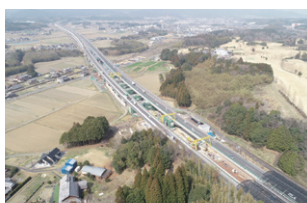
新名神高速道路（高野高架橋）
