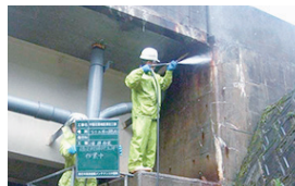
塩分洗浄(道路構造物)
