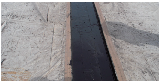
マトリクス502合材を舗設・転圧後、その上をバインダーでさらに被覆
