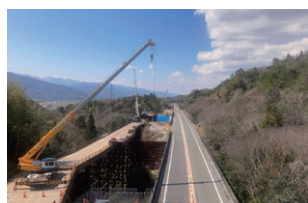
徳島自動車道（山根谷第一橋）
