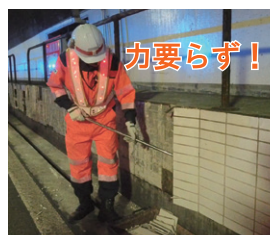
③ ケレン棒をタイルの背面に差し込むとタイルが簡単に剥がれ落ちます
