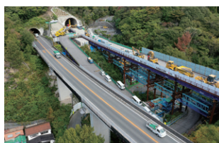
広島県道路（福浦川橋）
