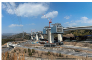
新名神高速道路（成合第一高架橋）
