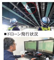
■ドローン飛行状況 ■撮影動画から構造物の状態を把握
