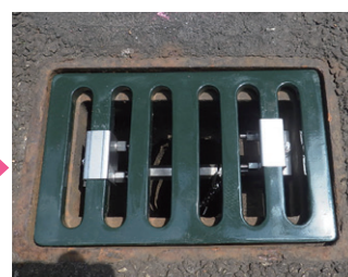
施工後の柵蓋 ※1
