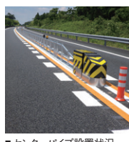
■センターパイプ設置状況
