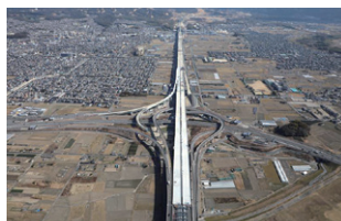
新名神高速道路（城陽高架橋）
