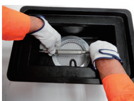
横張り軸金具取付
