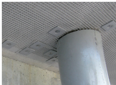
排水管周辺も施工が容易
