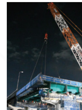
1000t吊りクレーンによる橋の一括架設
