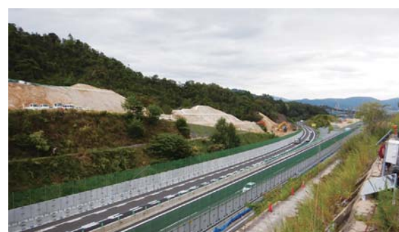
② 令和4年9月（拡幅工事）
