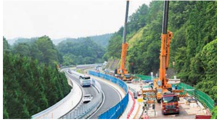
リニューアル工事状況（床版取替）
