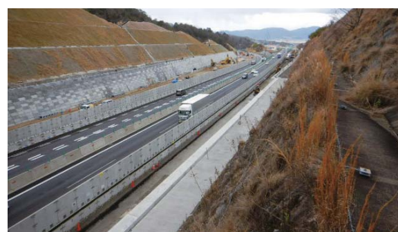
④ 令和6年2月（拡幅部 舗装工事）
