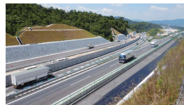
⑤ 令和6年7月（拡幅部 舗装工事）
