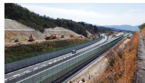
③ 令和5年3月（拡幅工事）
