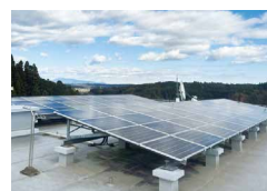
社屋上への 太陽光パネル設置 (九州支社 宮崎高速道路事務所)
