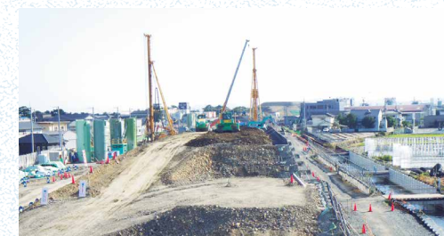
建設発生土の受け入れ
