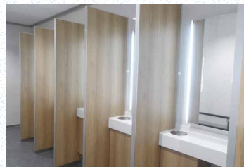
女子トイレのパウダーコーナー （九州道 北熊本SA（上））
