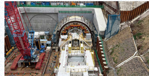
枚方トンネル掘削の準備工
