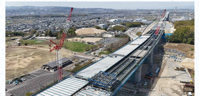
富野高架橋 上部工工事
