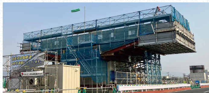
発志院北第一高架橋 下部工工事
