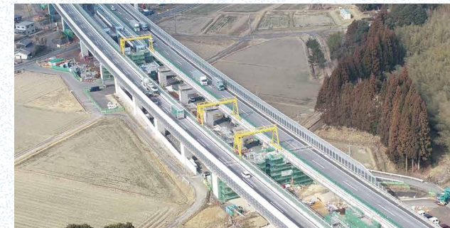
甲賀土山IC～信楽IC 6車線化工事
