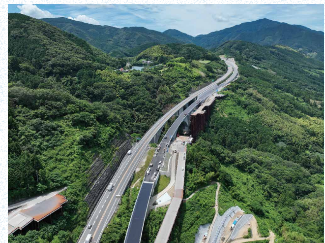
松山道(伊予IC～内子五十崎IC) 2025年4月 4車線化完成
