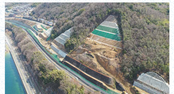
坂町植田地区～水尻地区における切土工事
