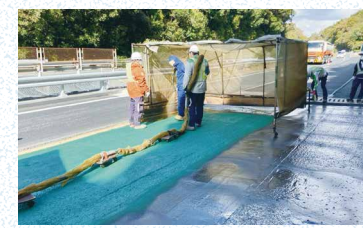
高性能床版防水施工状況
