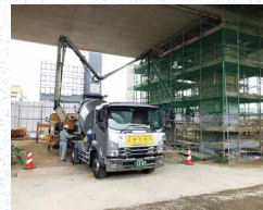
橋脚補強の施工状況
