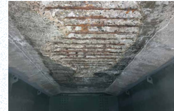
床版取替前(コンクリート床版下面)
