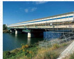
河川内での耐震補強工事
