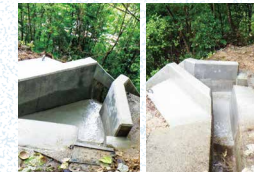
強化後の縦溝と集水ます
