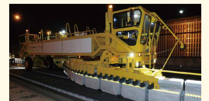
交通規制時間短縮のため、仮設防護柵を迅速に設置・撤去できるロードジッターシステムを採用
