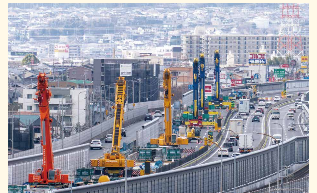
荒牧高架橋 終日車線規制による橋梁更新
