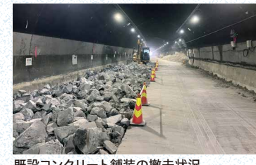
既設コンクリート舗装の撤去状況
