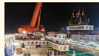
安倉高架橋 既設橋梁の解体・撤去
