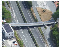
熊本地震で九州道を横架する県道が落橋
