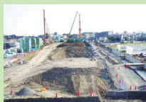
建設発生土再利用
