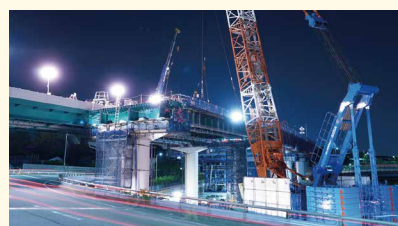
宮の前高架橋 1000tクレーンによる一括架設
