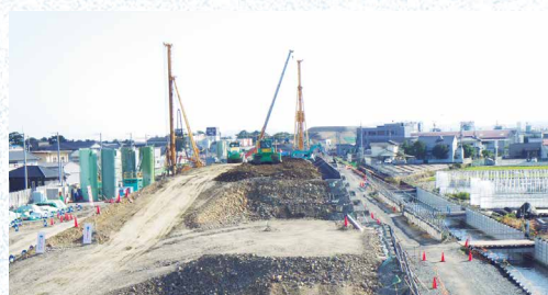
建設発生土の受け入れ
