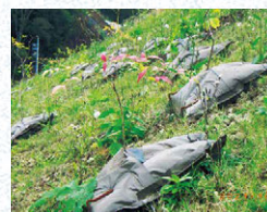
(左) 開通後13年経過し地域性苗木が樹林化した高速道路ののり面(新名神高速道路 信楽IC付近) (右) 地域性苗木の植栽パック
