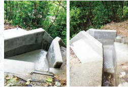
強化後の縦溝と集水ます
