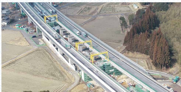
甲賀土山IC～信楽IC 6車線化工事
