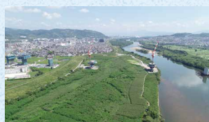
淀川橋下部工工事と鶴殿ヨシ原
