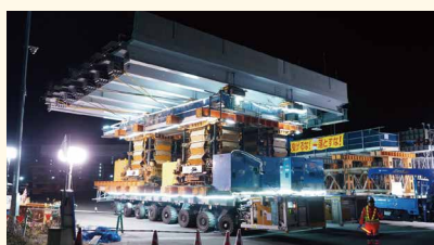
小浜橋 移動多軸台車による一括架設
