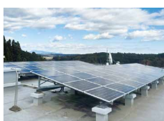
社屋屋上への 太陽光パネル設置 (九州支社 宮崎高速道路事務所)
