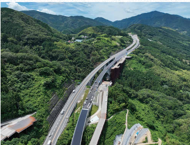
松山道(伊予IC～内子五十崎IC) 2025年4月 4車線化完成
