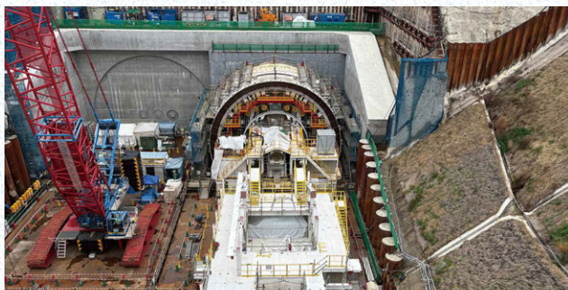
枚方トンネル掘削の準備工
