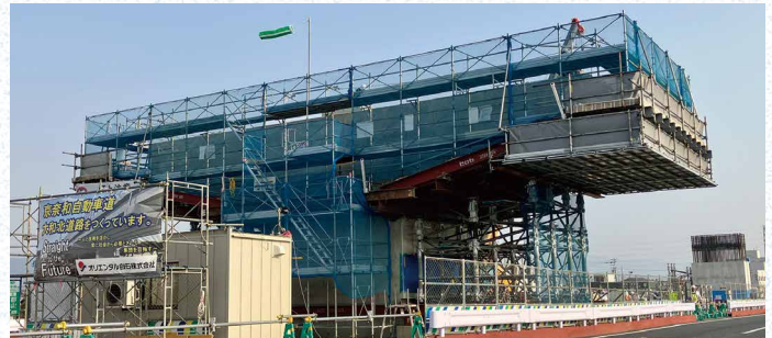
発志院北第一高架橋 下部工工事
