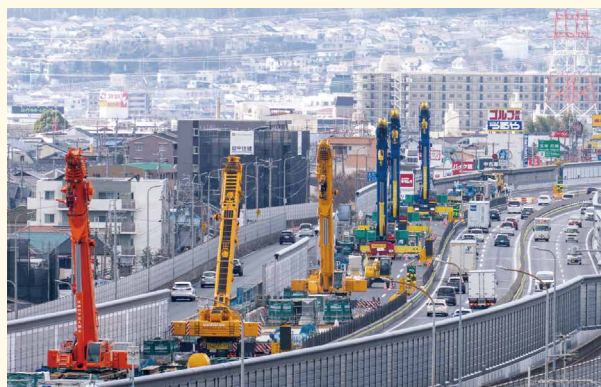
荒牧高架橋 終日車線規制による橋梁更新
