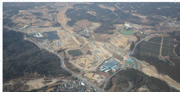
建設中の宇治田原ICと物流施設などの開発状況
