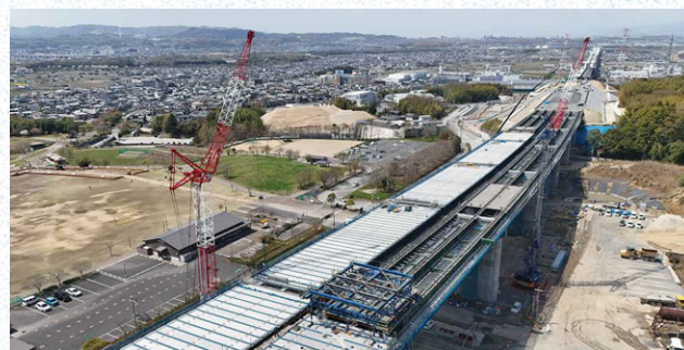
富野高架橋 上部工工事
