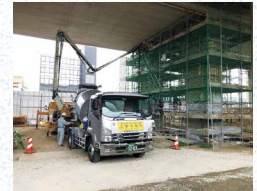
橋脚補強の施工状況
