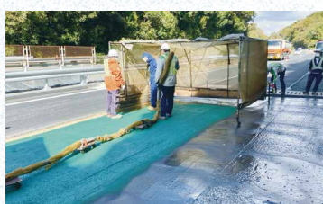
高性能床版防水施工状況
