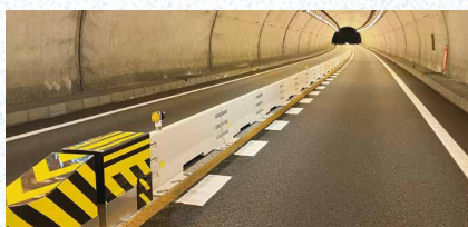
センターブロック
