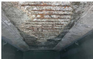
床版取替前(コンクリート床版下面)
