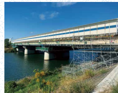
河川内での耐震補強工事
