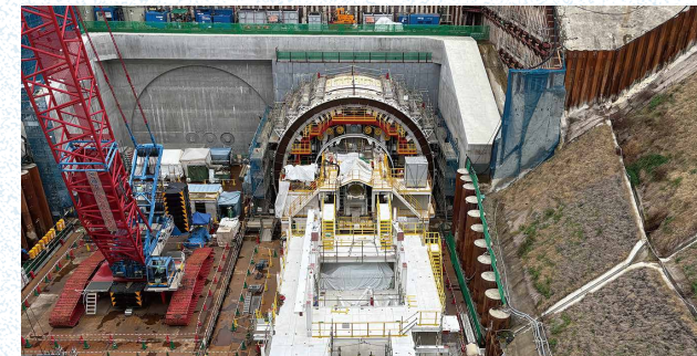
枚方トンネル掘削の準備工
