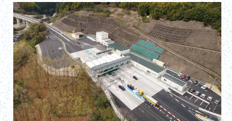
新たに設置した篠栗本線料金所
