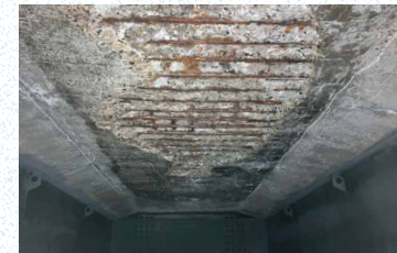
床版取替前(コンクリート床版下面)
