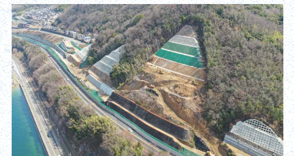
坂町植田地区～水尻地区における切土工事
