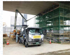
橋脚補強の施工状況
