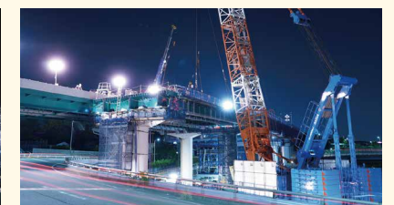
宮の前高架橋 1000tクレーンによる一括架設
