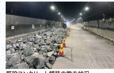
既設コンクリート舗装の撤去状況
