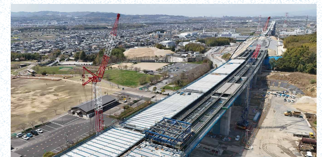
富野高架橋 上部工工事
