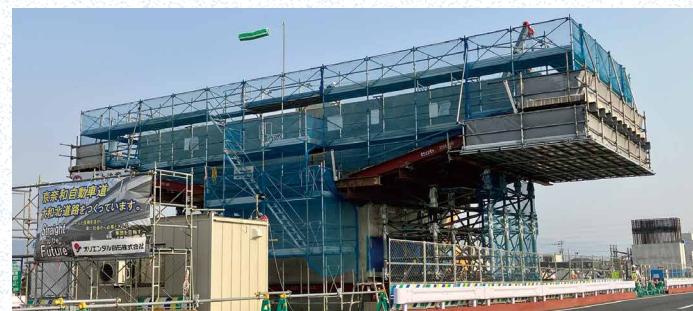
発志院北第一高架橋 下部工工事
