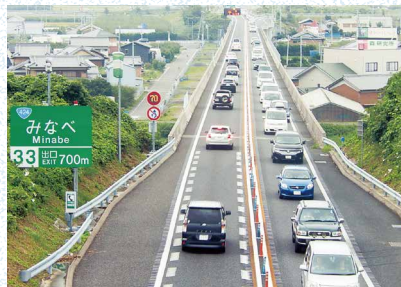
阪和道(印南IC～みなべIC)
