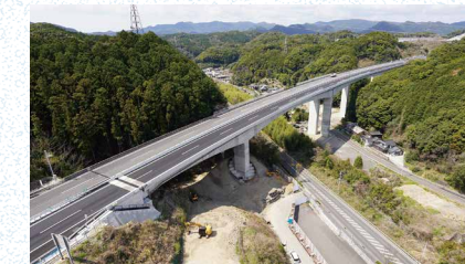
真串川橋付近
