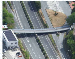
熊本地震で九州道を横架する県道が落橋
