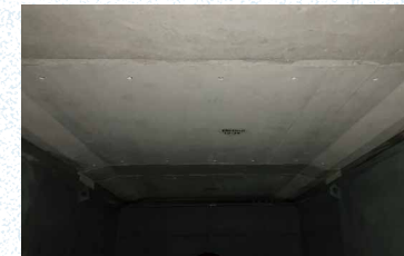
床版取替後(プレキャストPC 床版下面)
