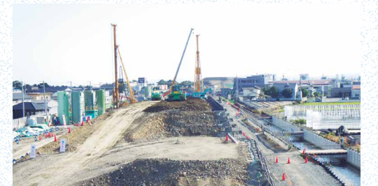
建設発生土の受け入れ
