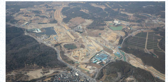
建設中の宇治田原ICと物流施設などの開発状況
