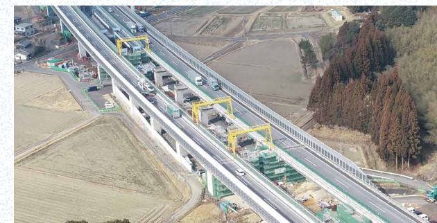
甲賀土山IC～信楽IC 6車線化工事
