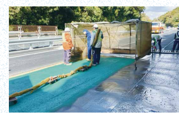
高性能床版防水施工状況
