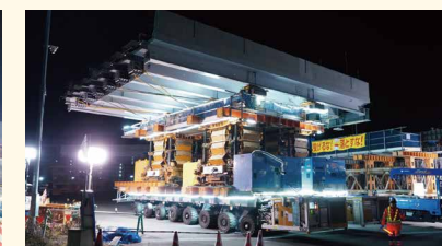
小浜橋 移動多軸台車による一括架設
