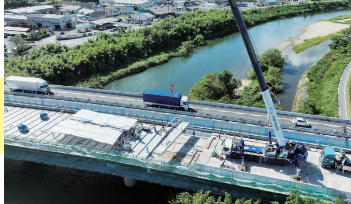
中国道（山口JCT-美祿東JCT）床版取替工事
