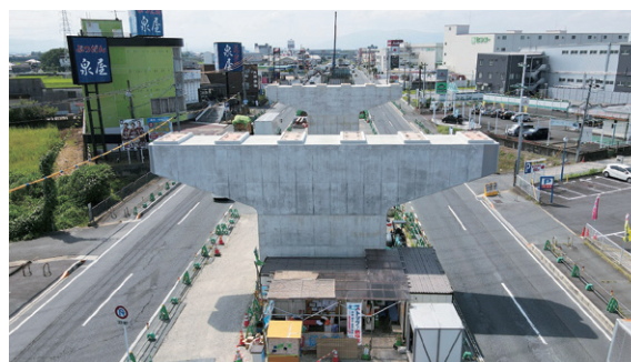
大和北道路 郡山下ツ道JCT付近
