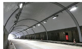
施工済状況(覆工補強)
