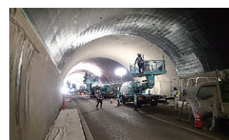
施工状況(覆工補強)
