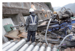
施工状況(グラウンドアンカー)
