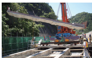
プレストレストコンクリート床版への更新
