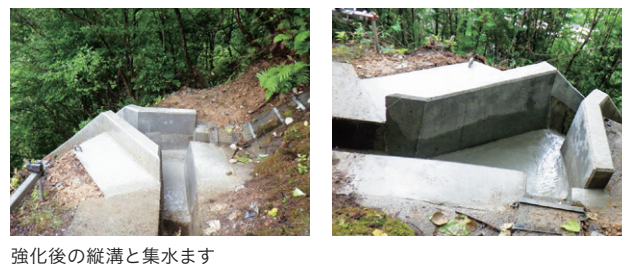
強化後の縦溝と集水ます
