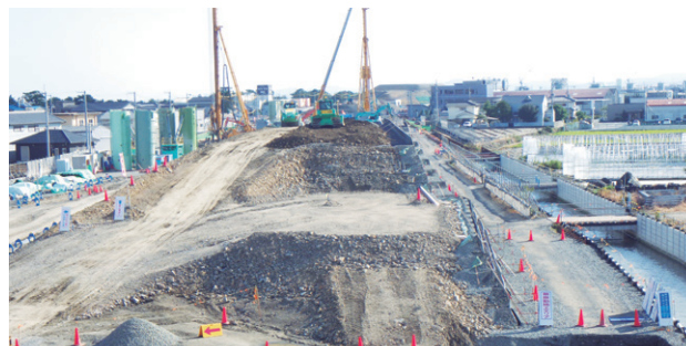
建設発生土の受け入れ
