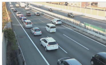
太宰府IC 出口手前約1kmの状況
