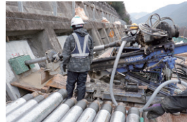
施工状況 (グラウンドアンカー)
