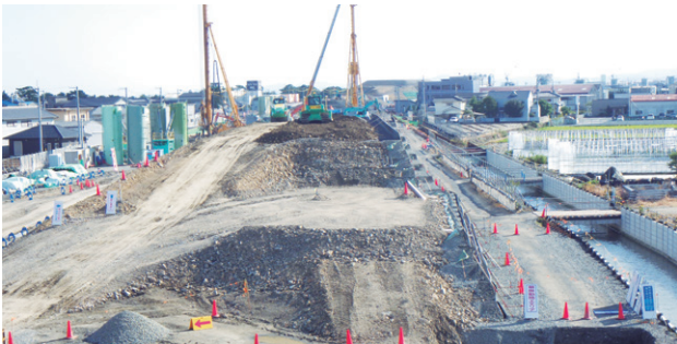
建設発生土の受け入れ
