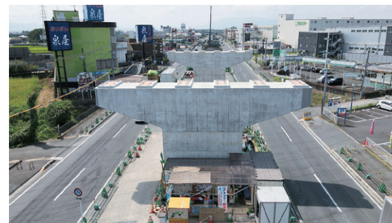
大和北道路 郡山下ツ道JCT付近
