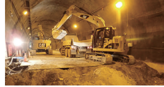
施工状況 (インバート設置)
