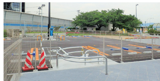
名神高速道路 桂川PA (上) ウェルカムゲート及び駐車場
