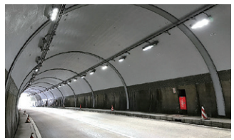
施工済状況 (覆工補強)
