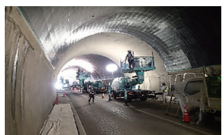
施工状況 (覆工補強)
