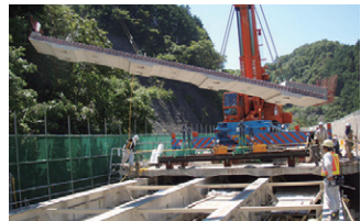
プレストレストコンクリート床版への更新
