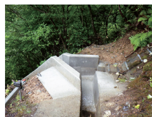
強化後の縦溝と集水ます
