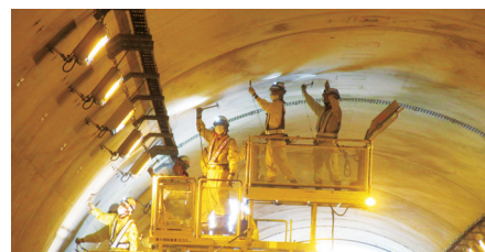
構造物の点検
