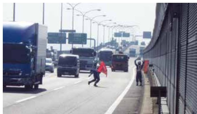
落下物排除の状況
