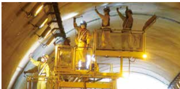
構造物の点検
