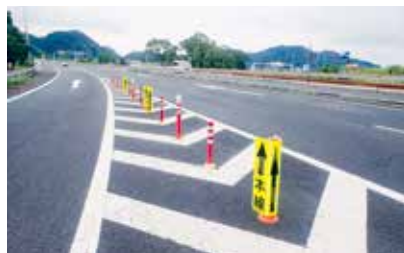
九州自動車道 加治木 JCT
