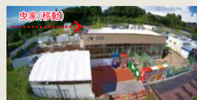
③新店舗移動(曳家)完了
