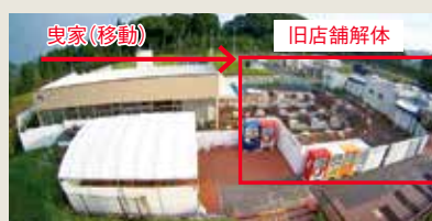
②旧店舗解体完了
