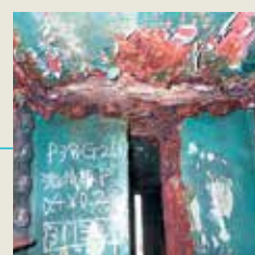
鋼部材の断面欠損
