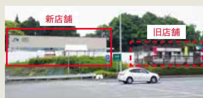
①新店舗建築完了
