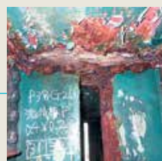
鋼部材の断面欠損
