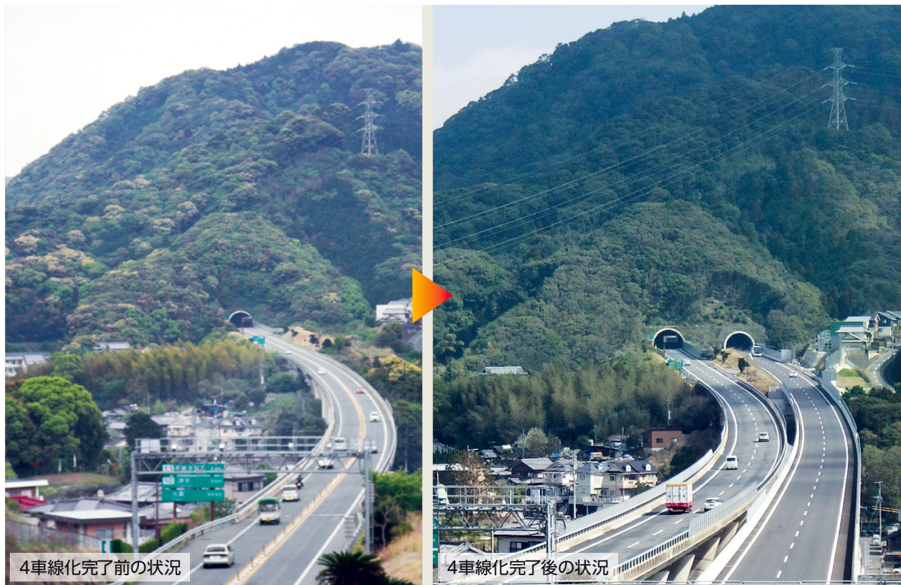
4車線化完了前の状況
