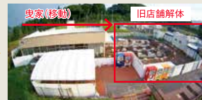
②旧店舗解体完了
