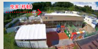
③新店舗移動(曳家)完了
