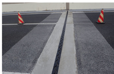
《伸縮装置の損傷（補修後）》
