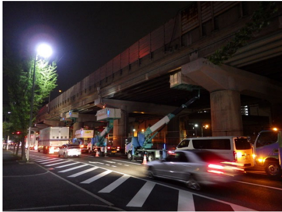
《コンクリート片剥落対策（橋梁）》
