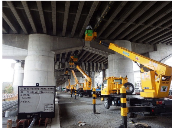
《コンクリート片剥落対策（橋梁）》
