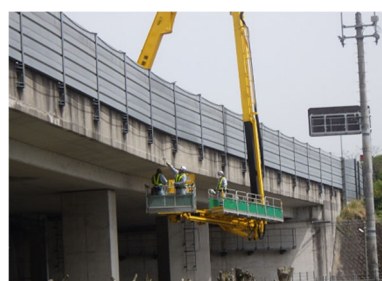
《橋梁下面の点検状況》
