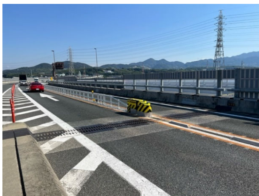
《区画柵（センターパイプ）の試行設置》
