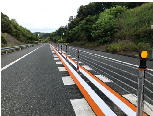
《ワイヤロープの設置》
