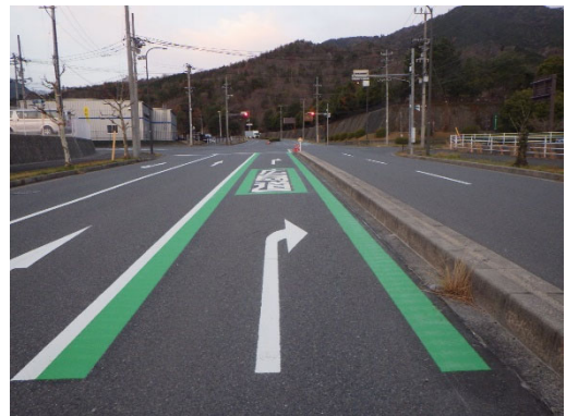
《逆走防止・誤進入対策》
