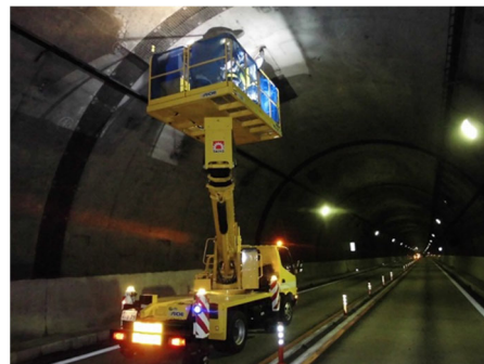
《トンネル覆工の点検状況》
