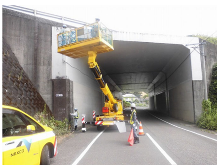
《ボックスカルバートの点検状況》
