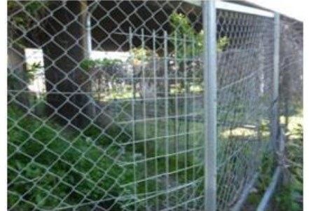
《立入防止柵の補修》
