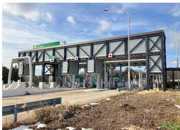
《料金所上屋通路》
