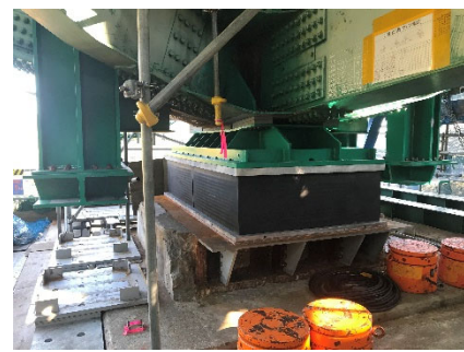
《補強後（支承取替）》
