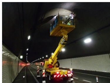
《トンネル覆工の点検状況》
