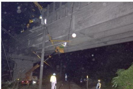
《橋梁下面の点検状況（鉄道交差）》
