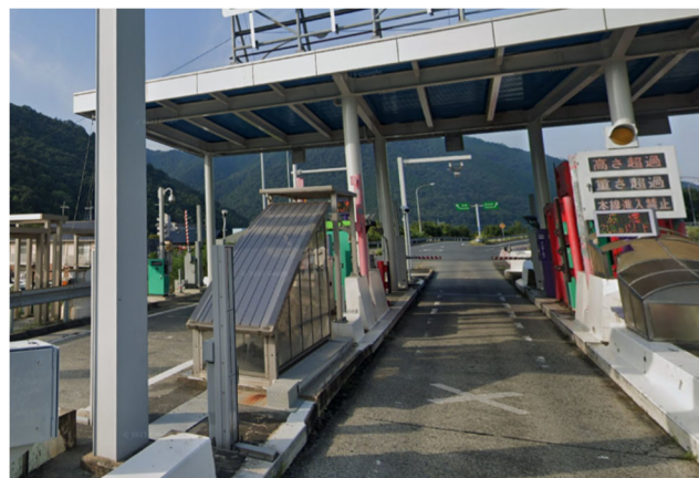
《料金所地下通路》
