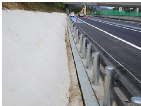
《埋設ケーブルのトラフ化》
