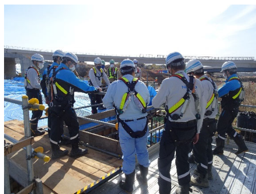
《安全パトロール実施状況》
