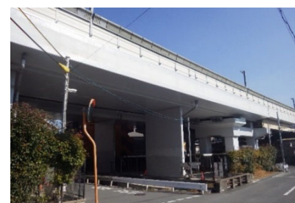
《橋梁上部工はく落対策（補修後）》
