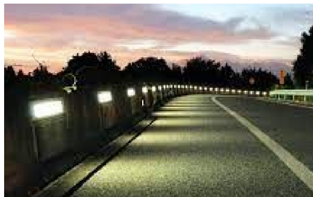
《道路照明のLED化・低位置化》
