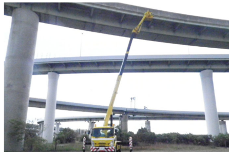
《橋梁下面の点検状況》
