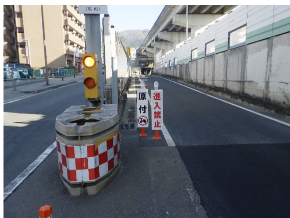
《ポストコーンカバーによる対策》
