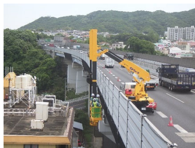
《遮音壁の点検状況》
