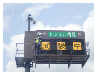
《情報板の点検状況》
