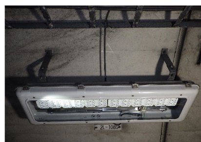
《トンネル照明の緊急補修（補修後）》
