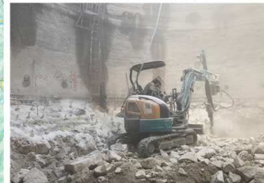
<P4橋脚基礎杭(硬岩部)の非火薬発破後の小割作業状況>
