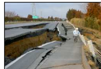
常磐道 水戸～那珂間
