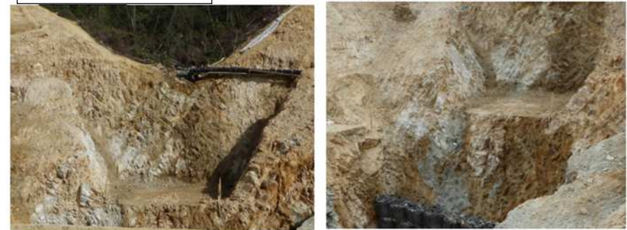
掘削時の岩盤状況
