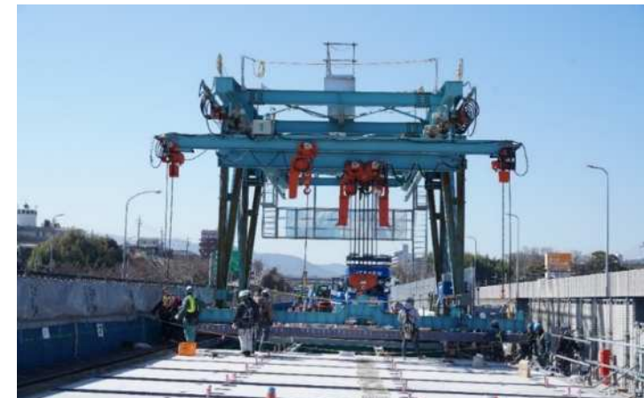
中国道における床版取替状況
