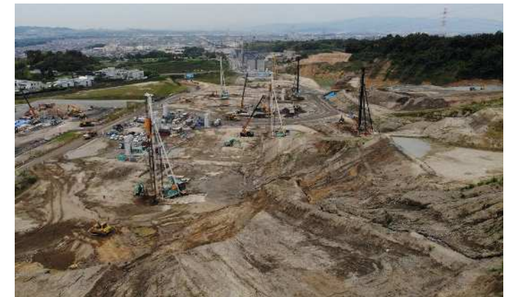
地盤改良施工状況
