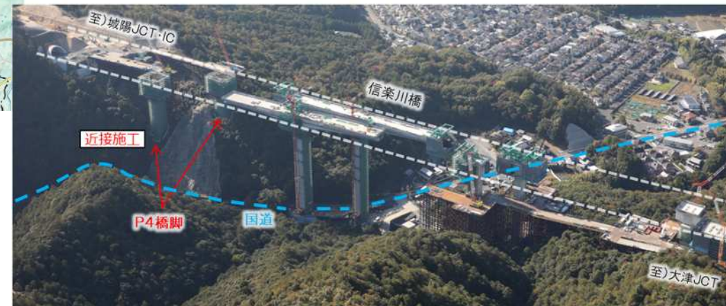
信楽川橋の状況(2024年11月撮影)
