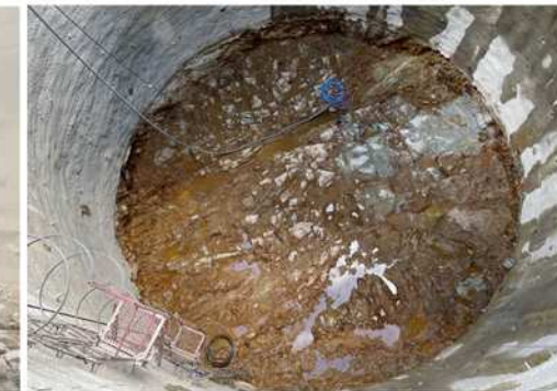
<P4橋脚基礎部の掘削完了状況>
