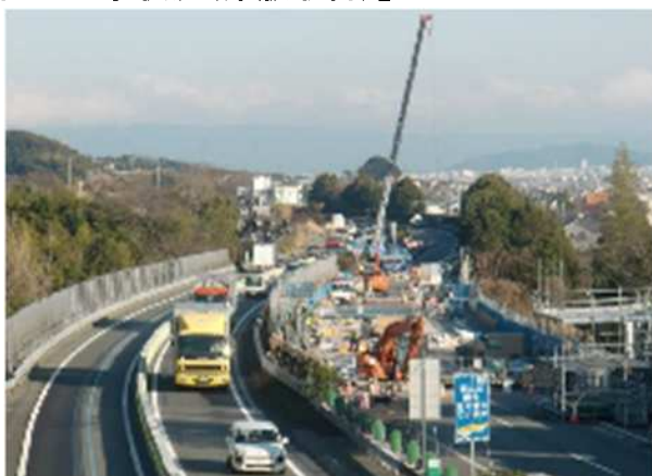
【図19 工事状況(床版取替)】
