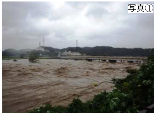
台風18号 (H25) における 滋賀県甲賀市野洲川の状況
