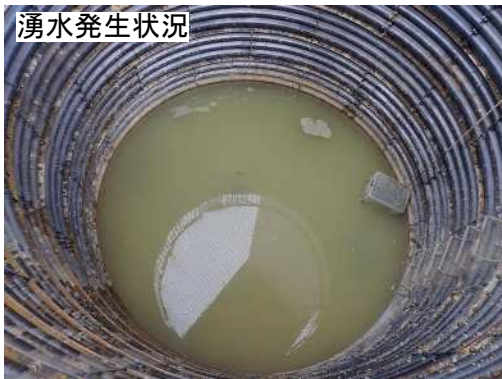
湧水対策工（薬液注入工）の追加
