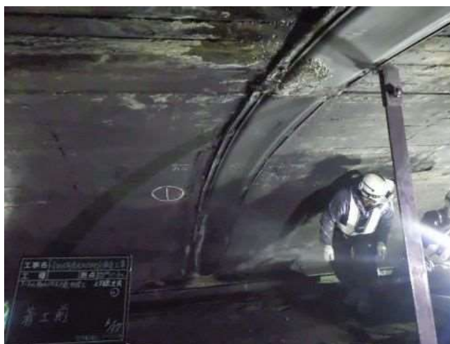
【漏水防止樋取替】
