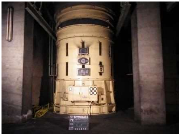
【換気設備更新】
