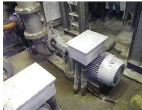
【排水ポンプ更新】
