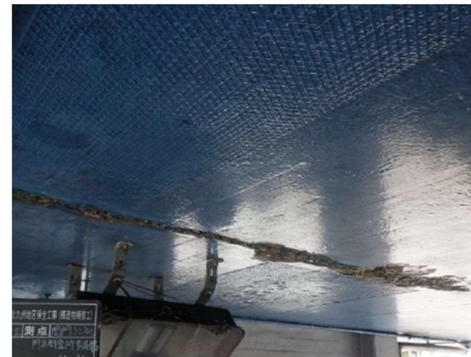
【料金所上屋構造物補修】
