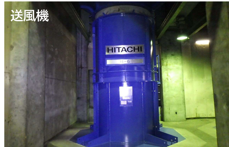
トンネル内の換気設備
