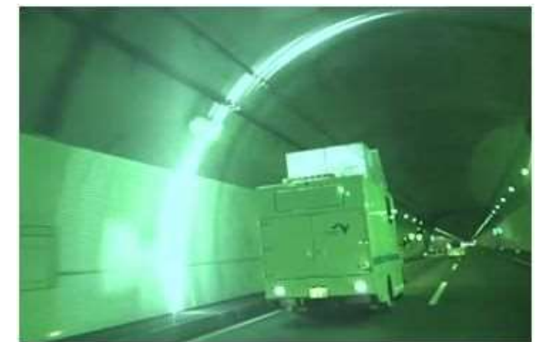
トンネル覆工調査
