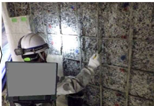
2. 錆除去・防錆処理
