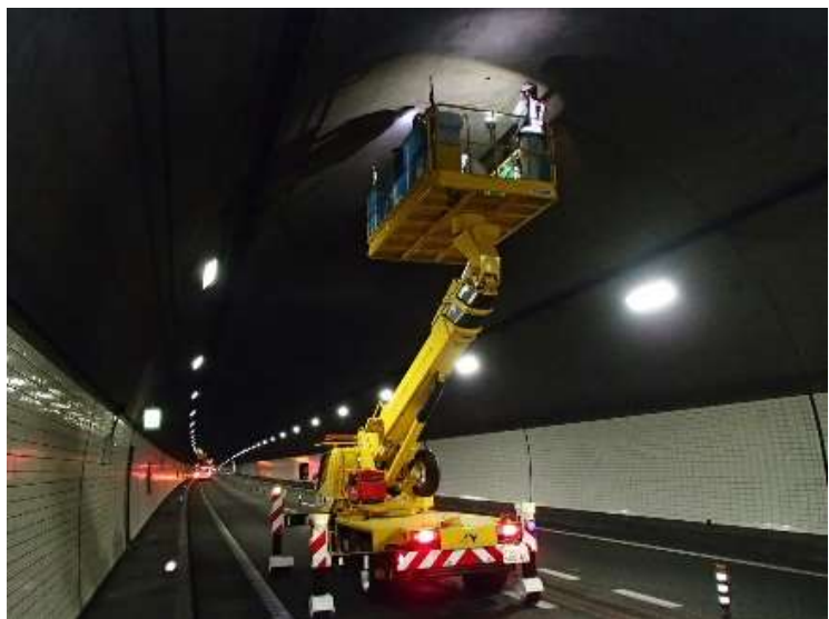
点検例) トンネル覆工点検 (写真は他路線での状況)
