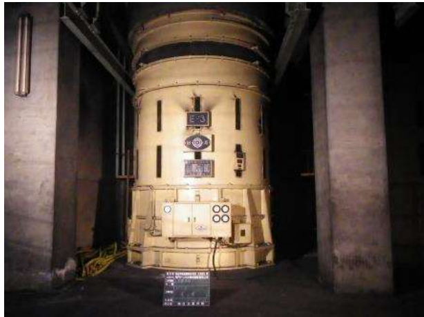
【換気設備更新】
