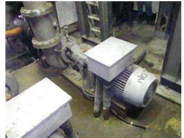
【排水ポンプ更新】
