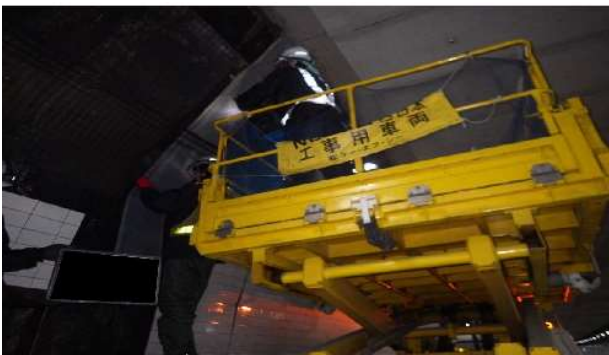
1. 足場（高所作業車等）
