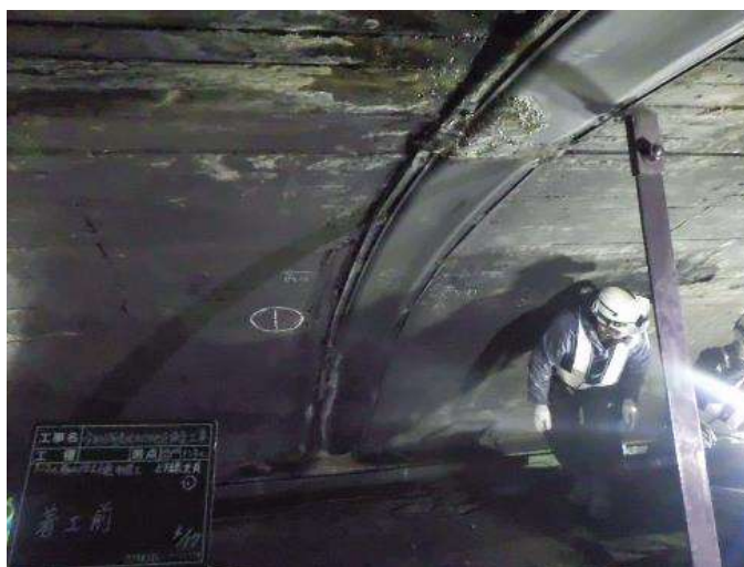
【漏水防止樋取替】
