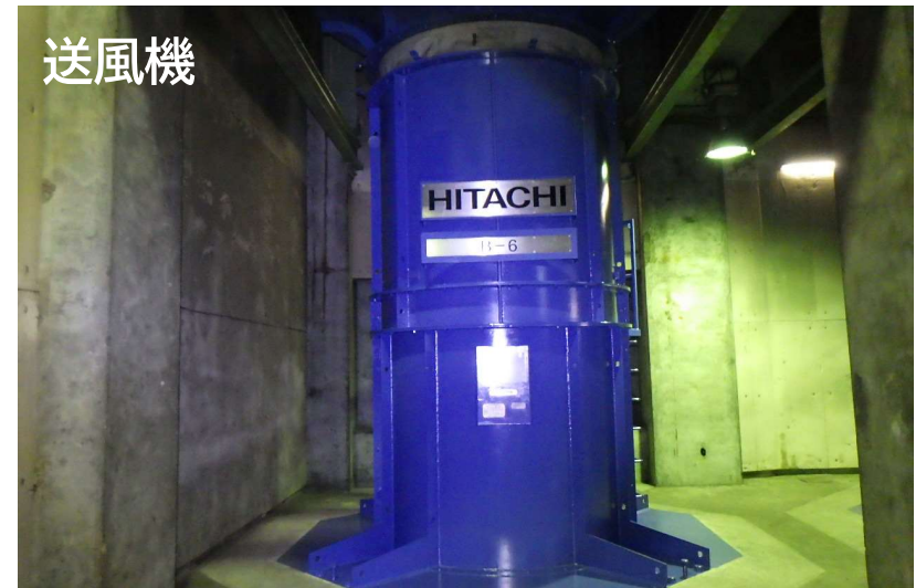
トンネル内の換気設備
