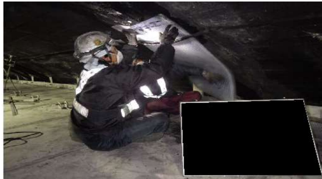
2. 漏水防止シート取付
