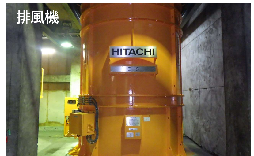
トンネル内の換気設備
