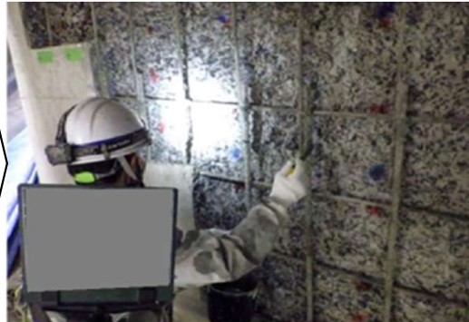
2. 錆除去・防錆処理
