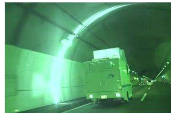
トンネル覆工調査
