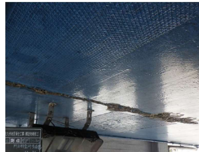
【料金所上屋構造物補修】
