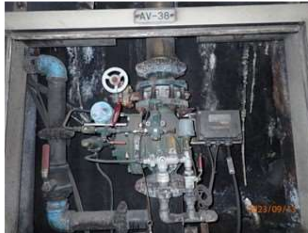
【非常用設備更新】
