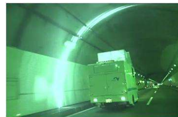
トンネル覆工調査
