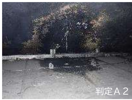
① S5区間 覆工からの漏水状況
