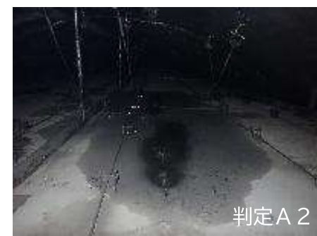
③ S1区間 覆工からの漏水状況
