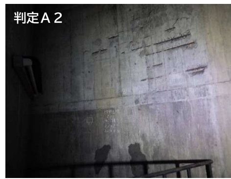
B 3 階エレベーターシャフト壁面にはく離
