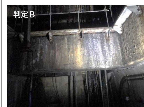
B14階フロア壁面に漏水
