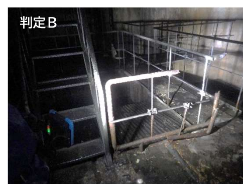
B13階フロア手摺破損
