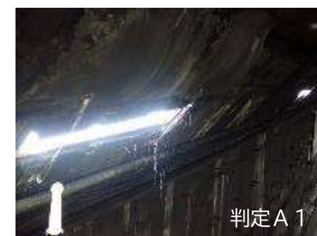
④ S1区間 覆工から車道部への漏水状況
