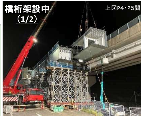
橋桁架設中 (2/2)
