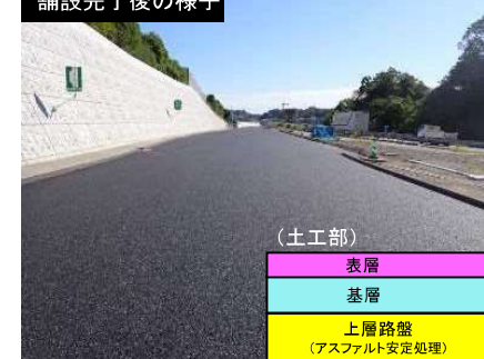
舗設完了後の様子
