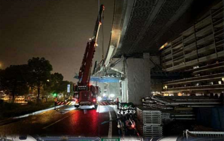
②吊り支保工設置状況
