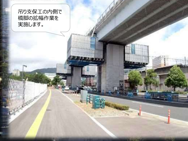
②吊り支保工設置完了
